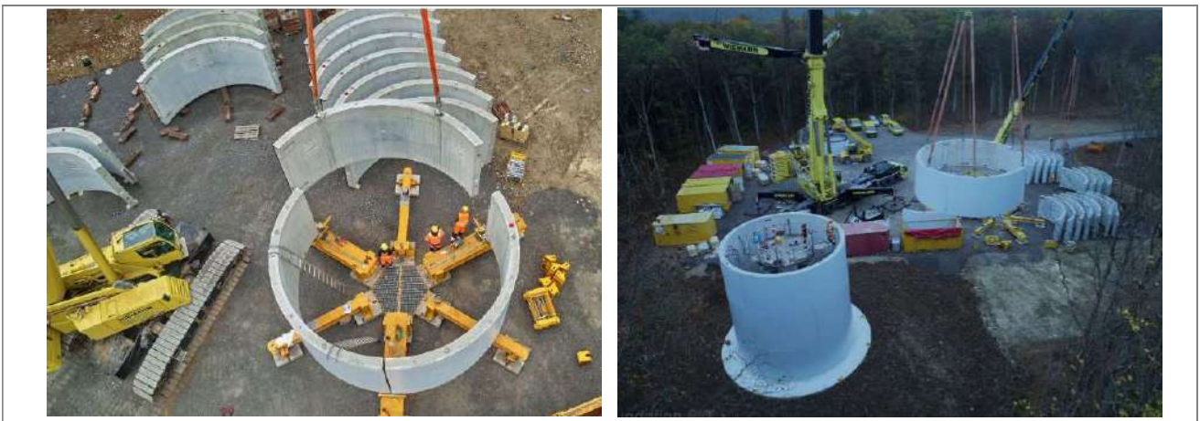
Abbildung 12: Turm des Typs TCS164B-XX / TCS179-00, Errichtung des Keystones (links) und der Section (rechts)
