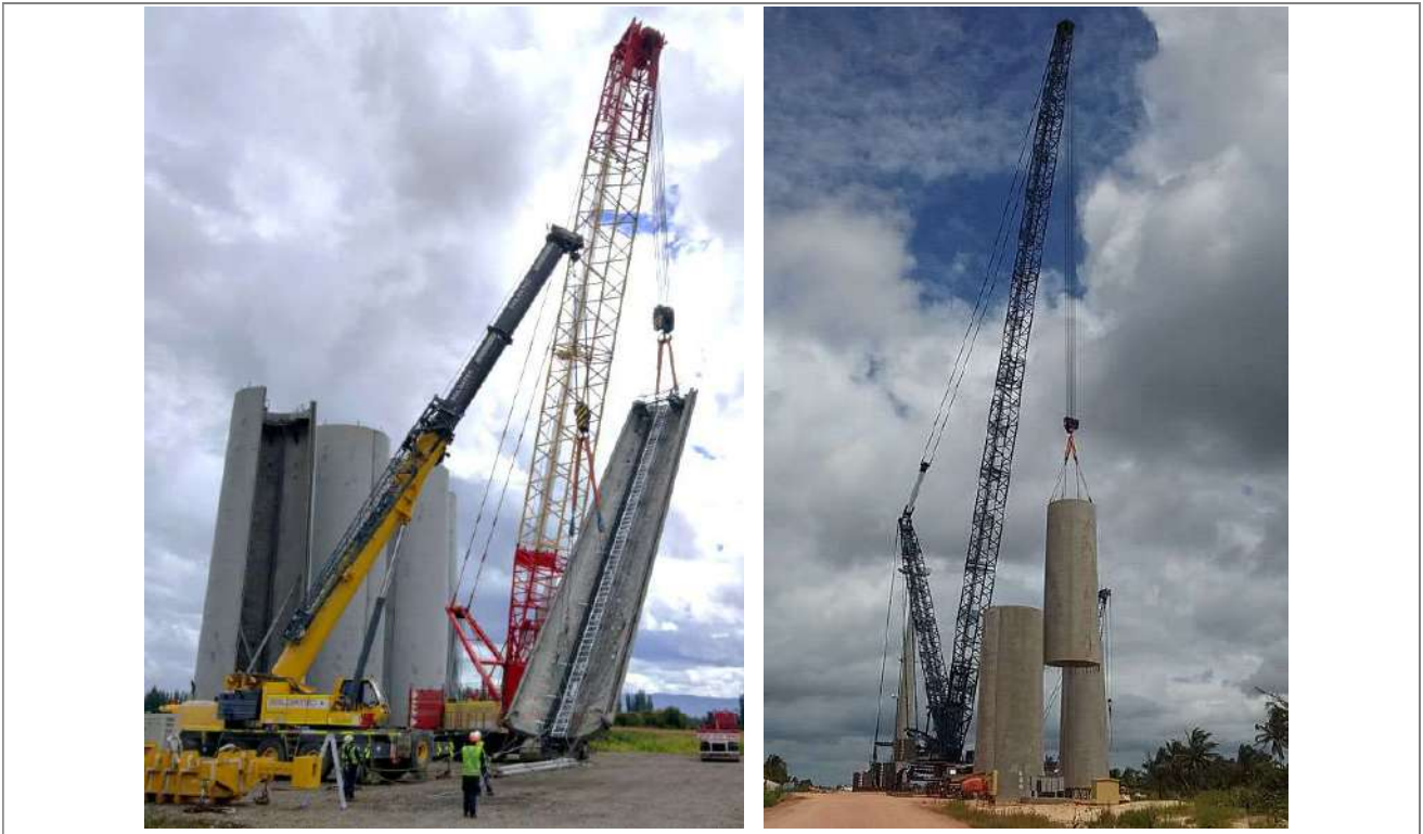
Abbildung 11: Vormontage (links) und Montage (rechts) von Turmsectionen aus Beton vom Typ TC100N/TC120N-01/TCS162-00/TCS168N-00/TCS179-00/TCS199-00
